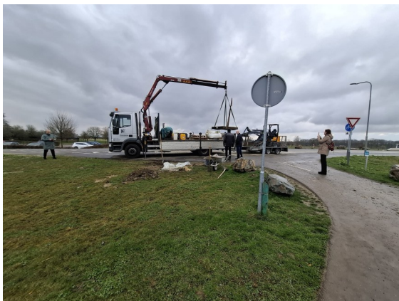
Het Speerpunt wordt geplaatst
